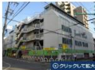
尼崎中央パーキング（写真：ジャパンエステート）
